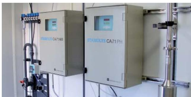
Système de mesure comprenant un dispositif de prise d'échantillons, ammonium, phosphates et nitrates
